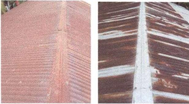
Foto1: Sustitucion de lamina troquelada aluzinc, calibre 26.
