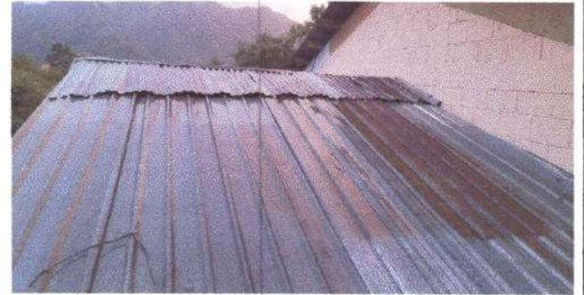
Foto 6: Sustitucion de lámina troquelada aluzinc, calibre 26.
